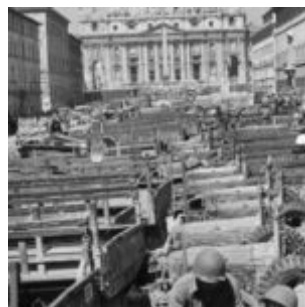
Lavori per la costruzione di via della Conciliazione
