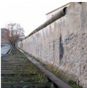
Il Muro dopo la caduta a Niederkirchnerstraße;
