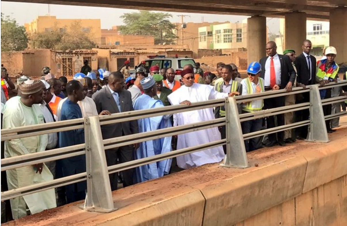
Il Presidente della Repubblica del Niger visita il cantiere del cavalcavia Diori
