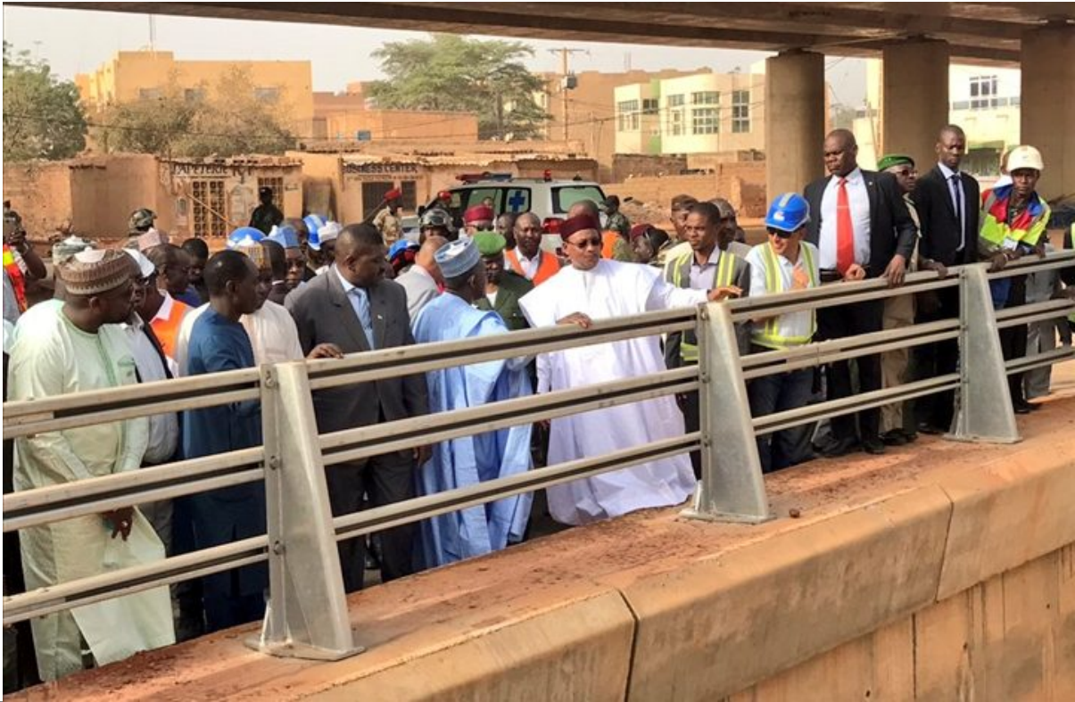
Il Presidente della Repubblica del Niger visita il cantiere del cavalcavia Diori
