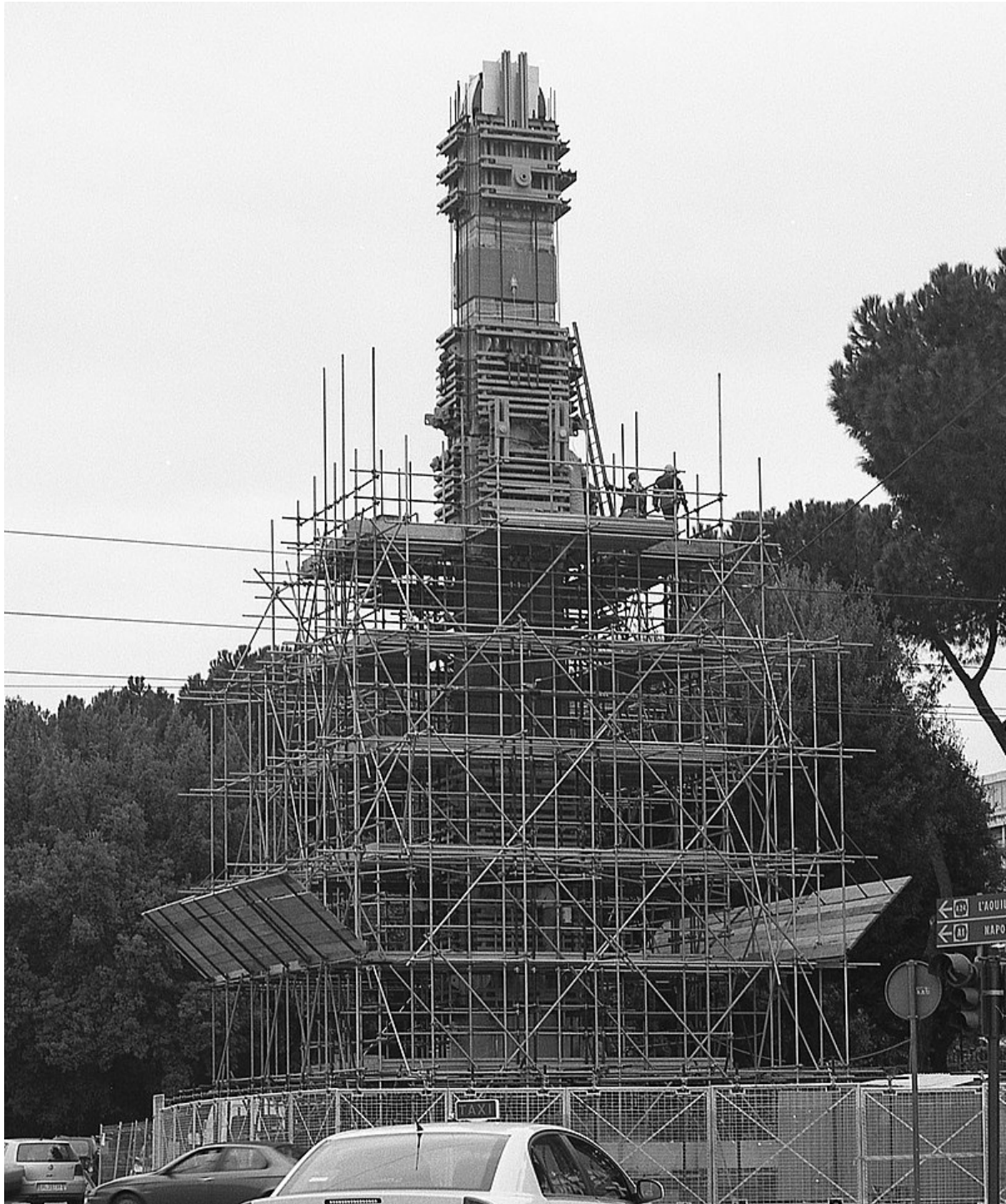
Impalcatura per il taglio/smontaggio dell'obelisco (28 ottobre 2003)
