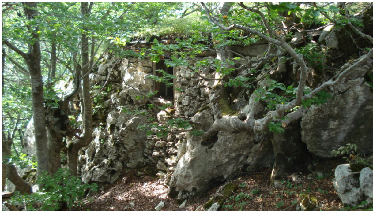
Abitazione del pittore sulla cima del Monte Marrone, realizzata dallo stesso Moulin utilizzando esclusivamente materiale locale e tirando i muri a secco (foto di Antonella Nigro)
