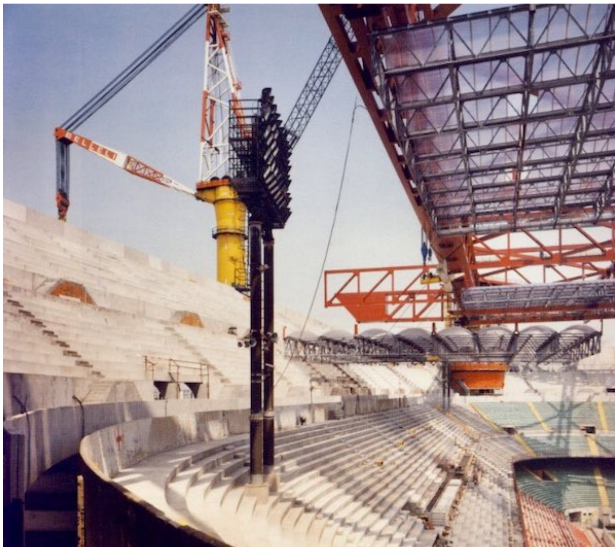
Lavori in corso a San Siro in vista di Italia '90
