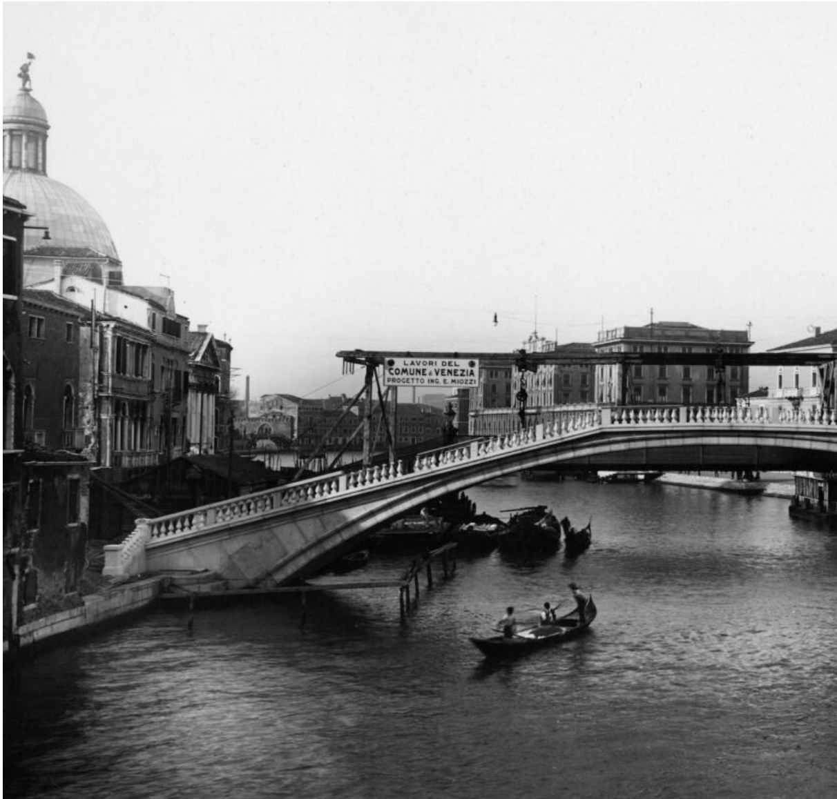
Ponte degli Scalzi
