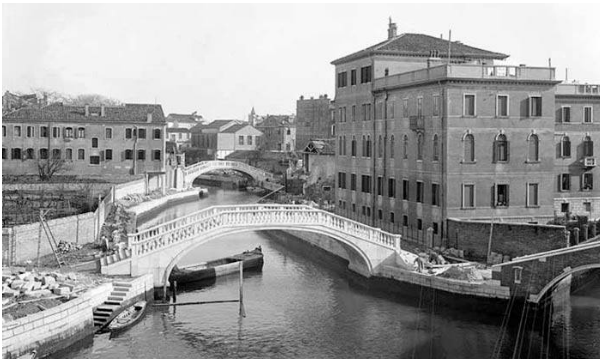
Ponte Rio Novo
